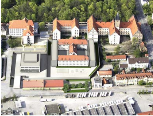
JVA Regensburg, Bestand und Neubauten (Torwache mit Fahrzeugschleuse, Betriebsgebäude und Hafriegel) Luftbild: Herbert Stolz, Regensburg; Visualisierung und Fotomontage: Karl + Probst
