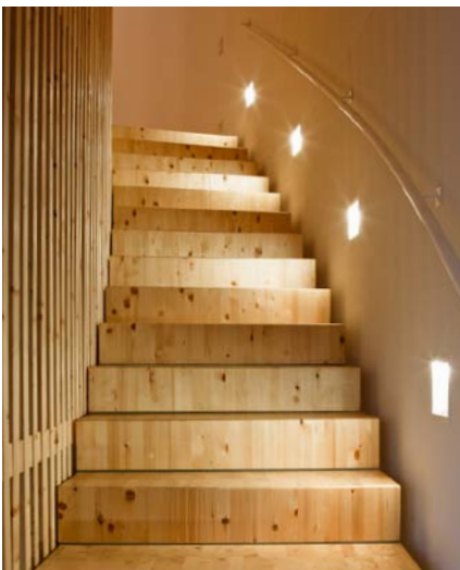
Treppe zur Empore
